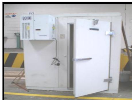
Dependiendo de las dimensiones de la puerta, se hace una simulación del armado de la misma o pre-ensamble para verificación del acabado final. Esto asegura que no se presenten problemas cuando se vaya a armar en sitio. Ver foto 16
