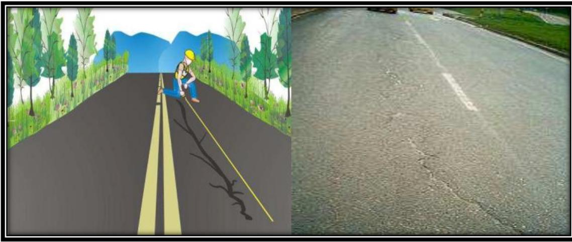
**Ilustración 17** Grieta Longitudinal
