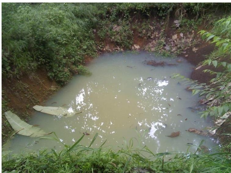
**Fotografía 6.-** Albarrada con problemas de filtración rápida y destrucción de sus muros
