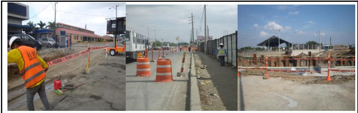
Fig. 31. Instalación de cinta plástica con la leyenda “PELIGRO”, en los ejes 6, 9 y ducto cajón del proyecto.
