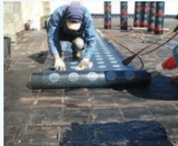
4. (Mb), Membrana bicapa, instalación lámina Super K 2500 sobre capa imprimante
