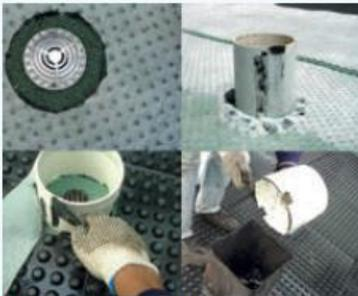
12. (Td / Cr) Tubo drenante y filtrante, proceso de instalación y colocación de Imptekfelt en tubo
