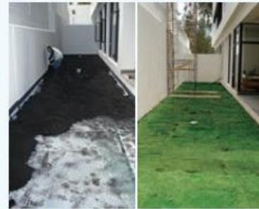
14. (Ptv) Protección pesada y capa vegetal sistema extensivo, proceso de instalación sobre capa Imptekdrén
