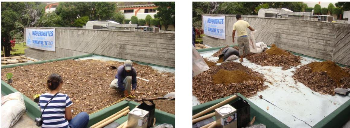
**Figura 9.** Colocación de la capa de tierra.
