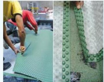
8. (Cdf) Proceso de corte de Imptek Dren con tijera, estilete, cuchilla y fácil traslape a razón de 2 nódulos
