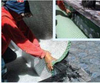
7. (Cdf) Instalación semiadherido de Imptek Dren sobre mebrana bicapa de impermeabilización
