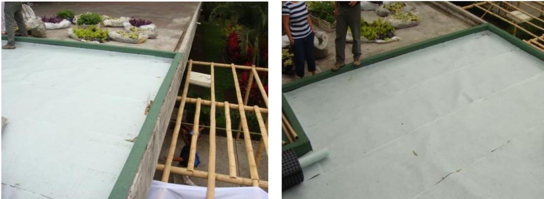
**Figura 8.** Colocación de la capa filtrante.
