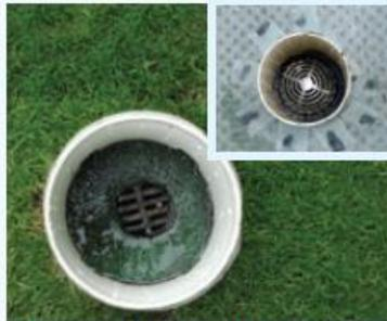
13. (Td / Cr) Tubo drenante y filtrante, proceso de sellamiento capa filtrante y funcionamiento con Ptv
