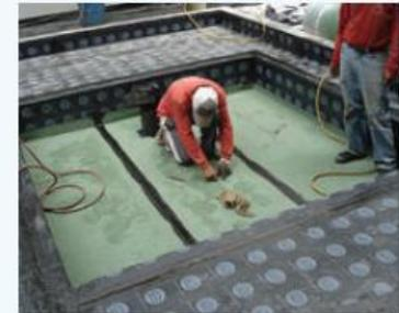
5. (Mb), Membrana bicapa, instalación 2da. lámina anti-raíz protegida o no protegida sobre Super
