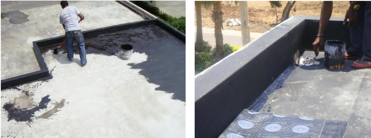
**Figura 6.** Sellamiento de la superficie para la impermeabilización.
