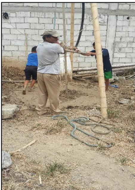
**ILUSTRACIÓN 8. FABRICACIÓN ARTESANAL DE POZOS PROFUNDOS**
