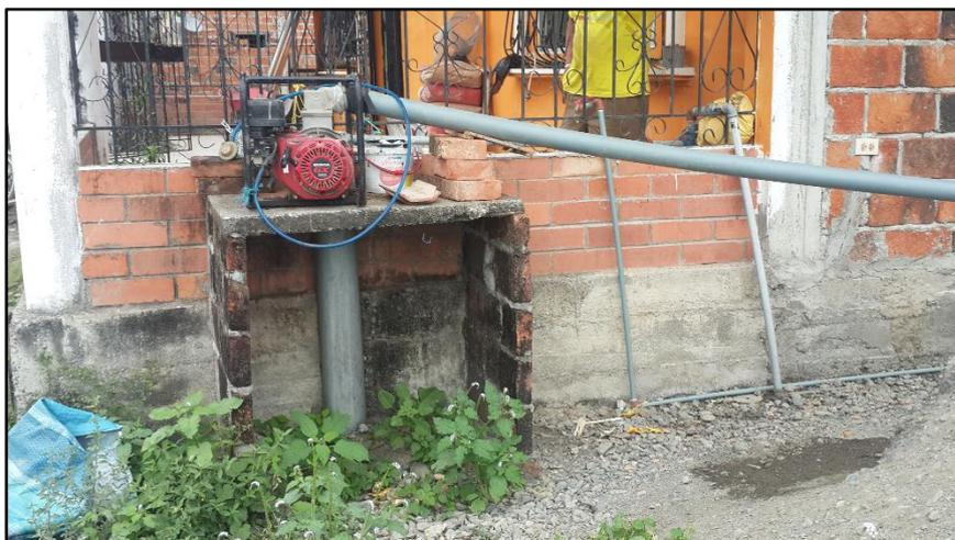
**ILUSTRACIÓN 9. CONEXIÓN A POZOS PROFUNDOS**
