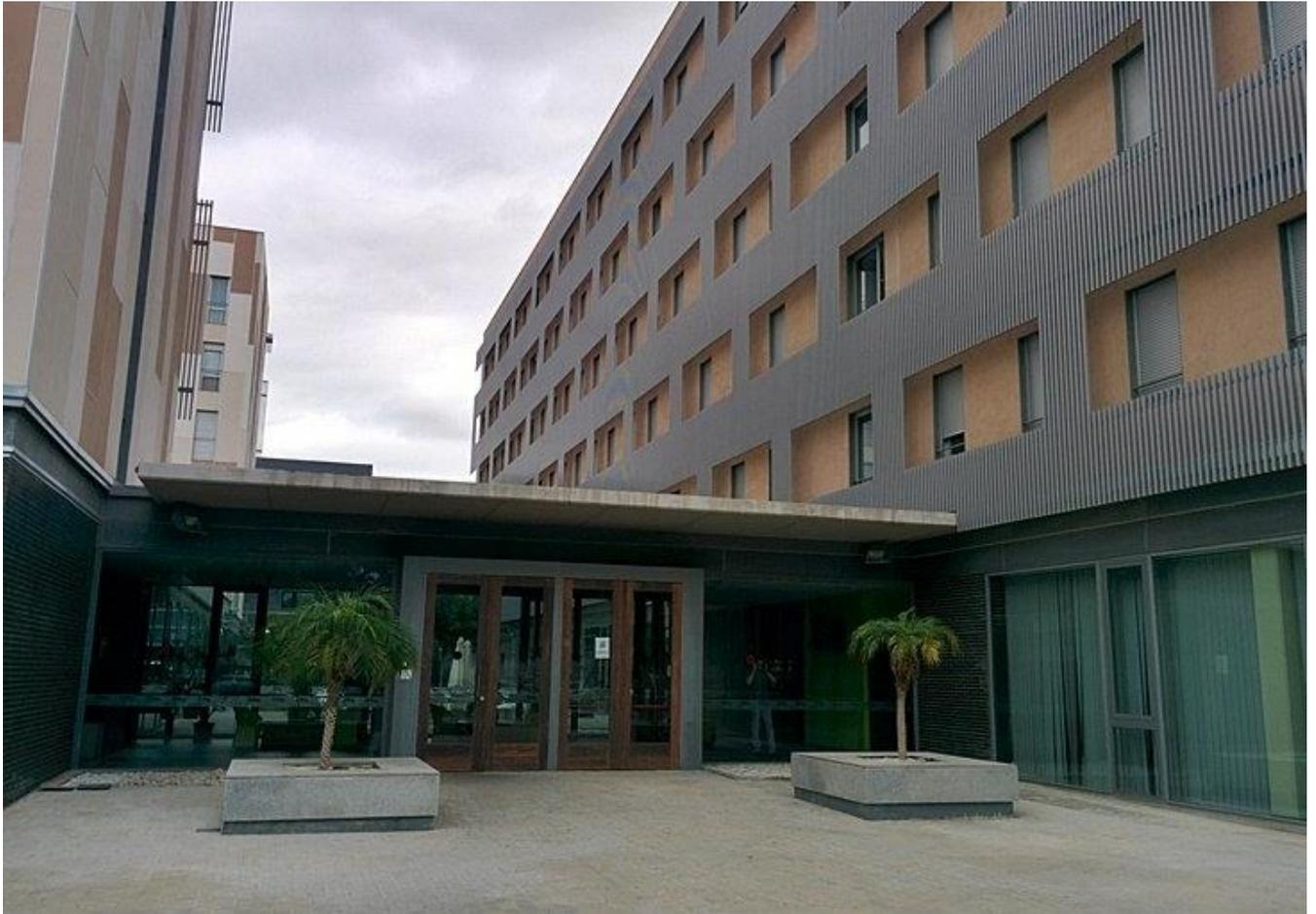
*Ilustración 15: Fachada de chapa galvanizada*
